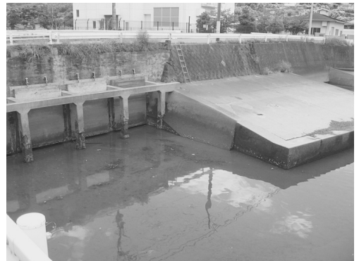
写真2 現在の百間排水口
