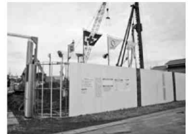
写真1 施設の工事現場
