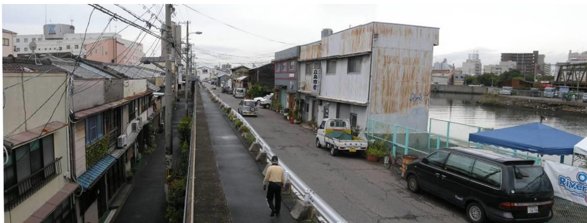
図 2-8 大阪市大正区の「0 m 地帯」。満潮時には川の水面は右道路下数十 cm に迫る。図中央の防潮堤は歩行者の身長程度の高さで、幅はわずか数十 cm である。図左方には住宅地が広がり、おおむね 2 階が防潮堤の高さである。
