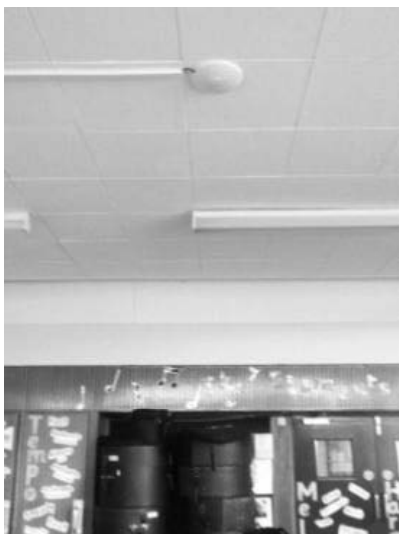
写真 2-9. 音楽室の天井
